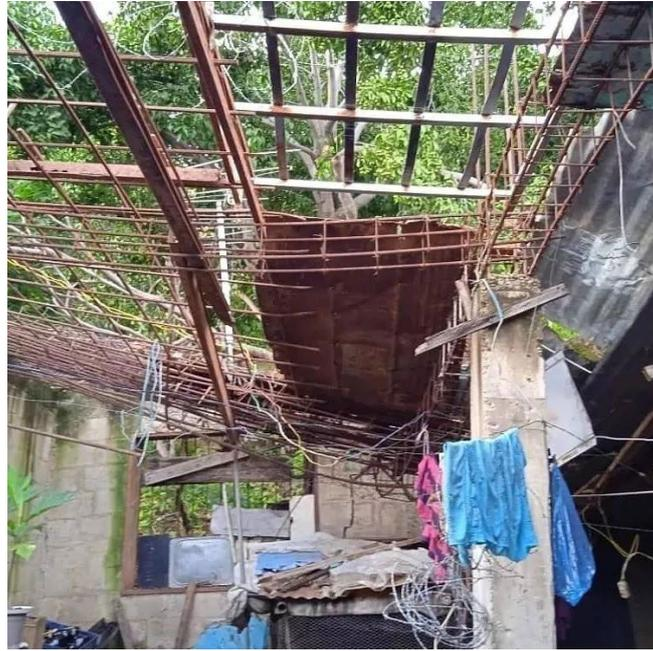
Figura 4. Daños ocasionados por la caída de una roca sobre el techo
