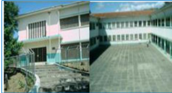
Figura.N.1. Imagen de la E.B José Ramón Camejo, fachada principal.
